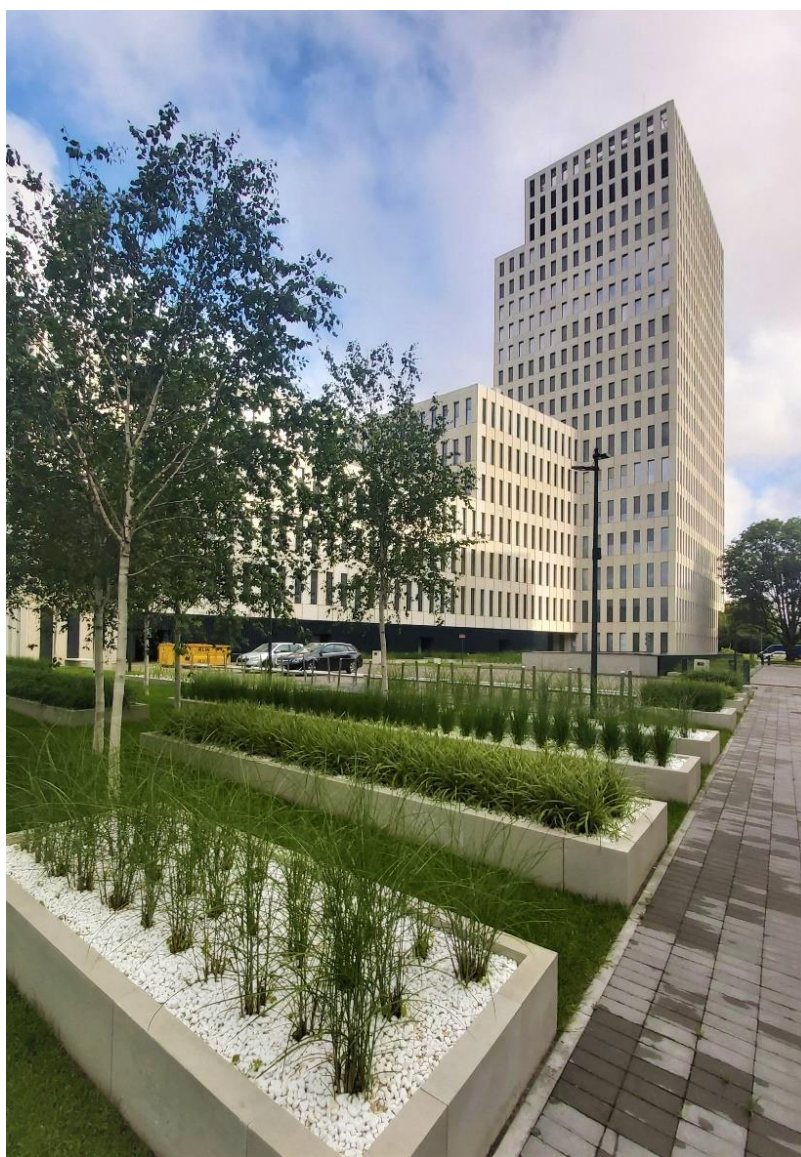
Budynek Transportowego Dozoru Technicznego z częścią konferencyjną, mieszkalną i gastronomiczną
